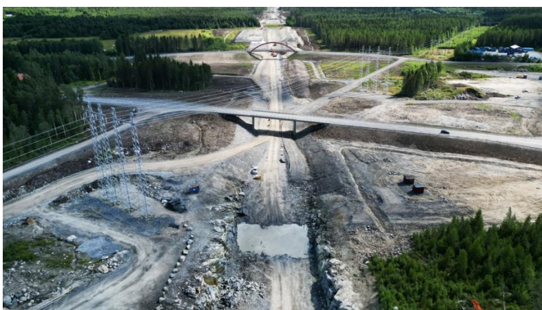
Figur 13 Den pågående byggnationen på sträckan Umeå - Dåva
